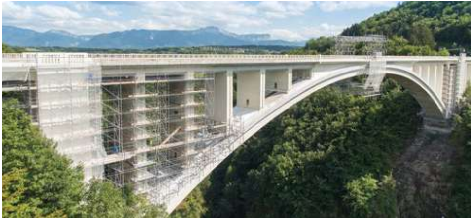
Chantier de mise en peinture d'un pont en béton
