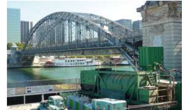
Pont ferroviaire en milieu urbain, catégorie C3
