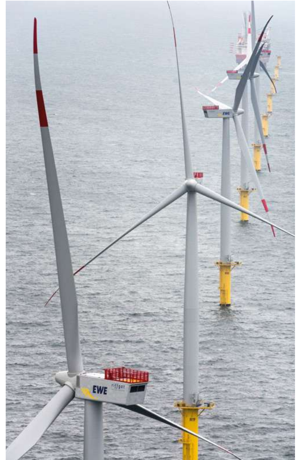
Éolienne offshore, partie haute en catégorie C5, partie immergée en Im4
