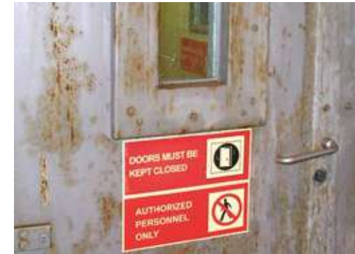
Corrosion d'une porte en acier inoxydable
