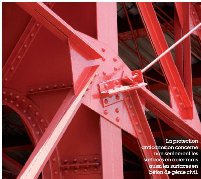
La protection anticorrosion concerne non seulement les surfaces en acier mais aussi les surfaces en béton de génie civil.
